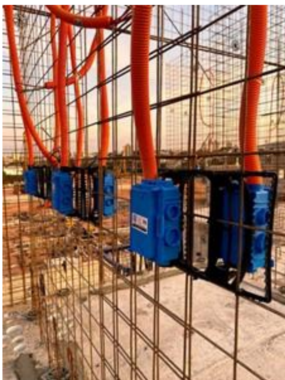
Aplicação do espaçador quadrado para paredes de 11cm-15cm
