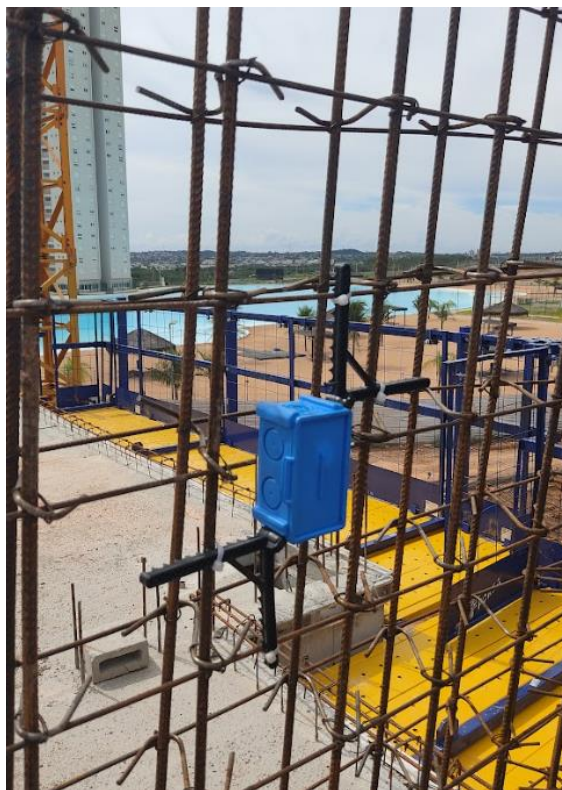
Aplicação de caixa malha dupla e rígida – Parede de 15cm possibilidade de aplicação em paredes de qualquer espessura
