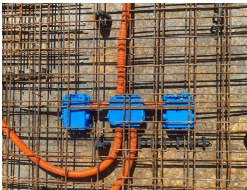
Montagem de caixa laje + caixa elétrica para sensores
