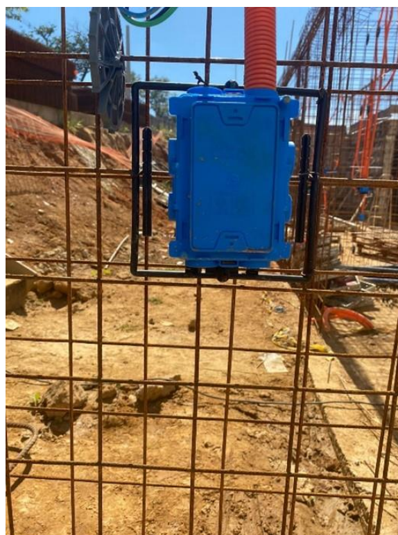
Aplicação do espaçador quadrado para paredes de 11cm-15cm
