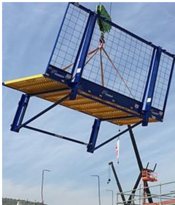
Içamento de andaime trepante em obra
