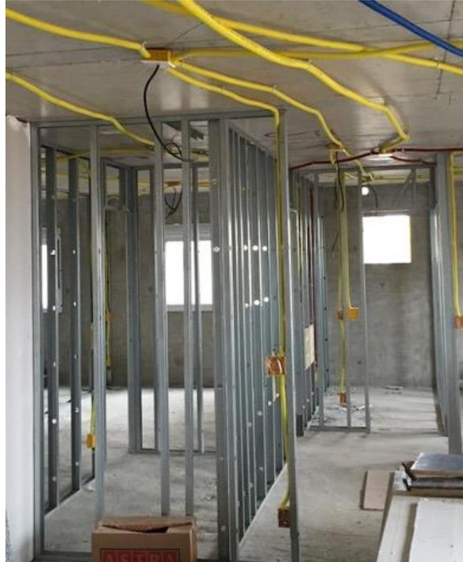
*Exemplo de conduítes pelo forro, entrando direto em paredes de drywall*
