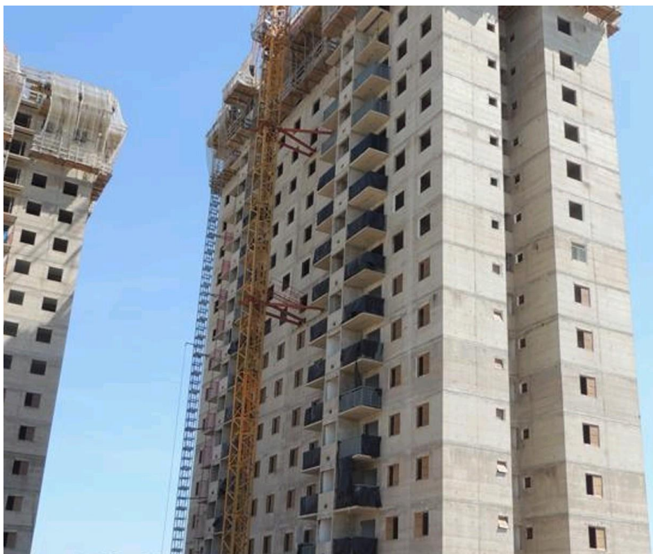
Edifícios altos em parede de concreto: conforme construção sobe, pressões de bombeamento e a qualidade da linha de transporte se tornam mais importantes
