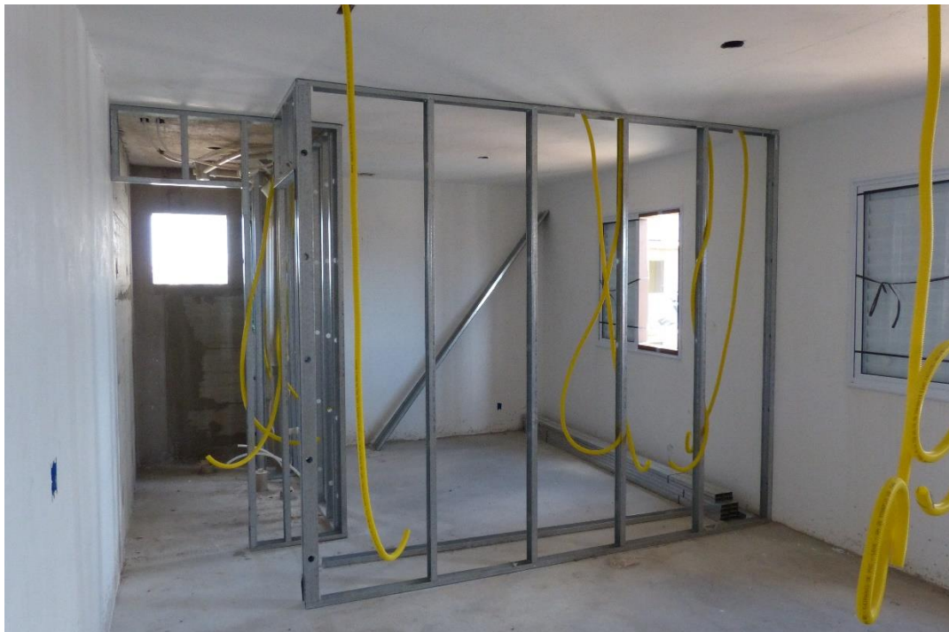
Vedações internas executadas em drywall
