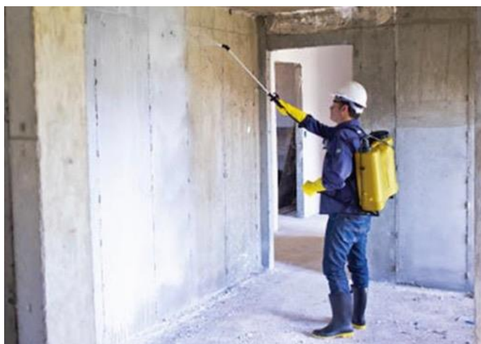
Aplicação de cura química nas paredes de concreto
