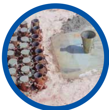
Recebimento do concreto no local de aplicação.
