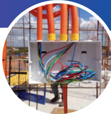
Uma variável importante para o bom desempenho do sistema parede de concreto é a interface das instalações elétricas e hidro sanitárias com o sistema principal – parede de concreto.
